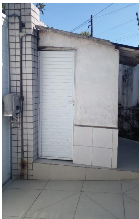
Local de Armazenamento Lixo Sêptico Campus II
